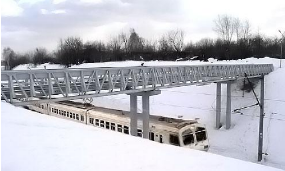
Kuva 8. Komposiiteista tehty ylikulkusilta Venäjällä.
