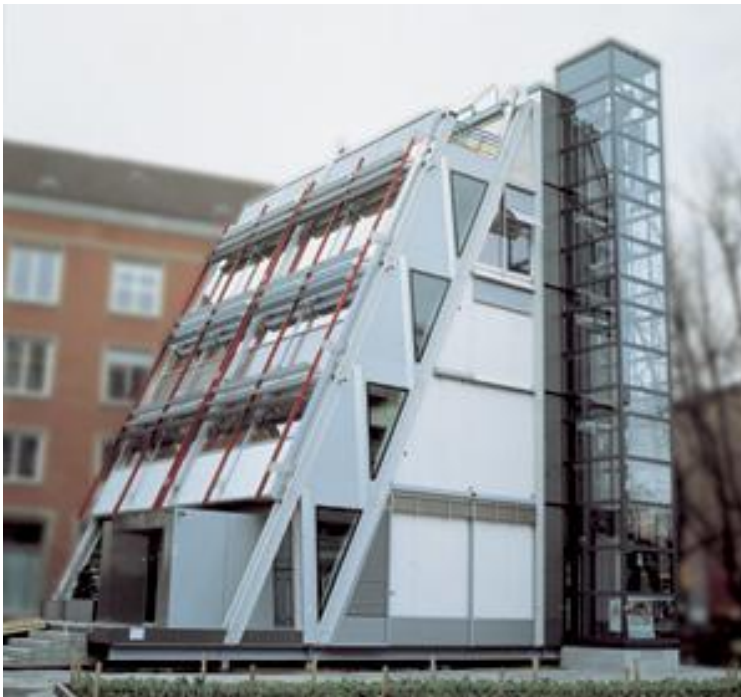
Kuvio 2. Kokonaan komposiiteista tehty rakennus.
