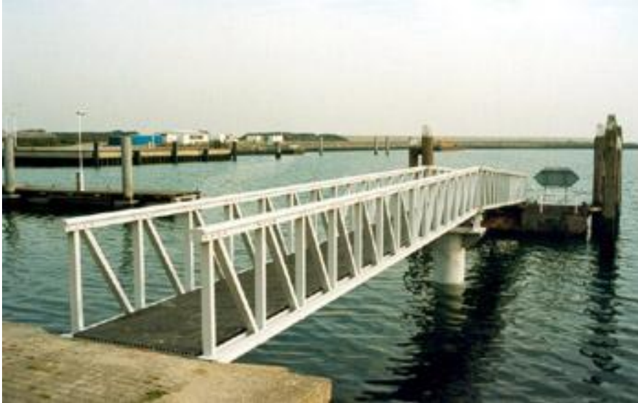
Kuva 5. Komposiittimateriaalista valmistettu laituri.
